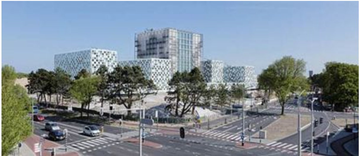
Photo : les bâtiments de la Cour pénale internationale, La Haye
